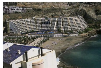
Construcción en zonas de alto valor o alto riesgo natural (ej. dunas de arena, ladera "activas")
