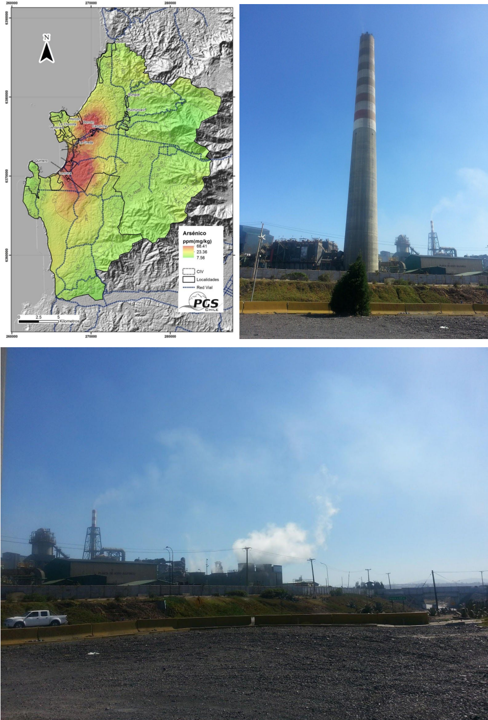
Figura 1. Puchuncaví, zona de exclusión ambiental. Arriba izquierda mapa de distribución de arsénico en suelo desde Ventanas (PGS, 2015). Arriba derecha y abajo fundición de Ventanas fotos de @pepline .
